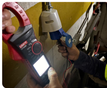
Pruebas eléctricas de seguridad.
