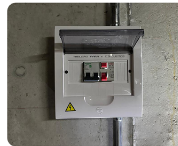
Verificación de protecciones.
