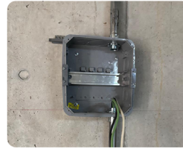
Tendido de conductores.
