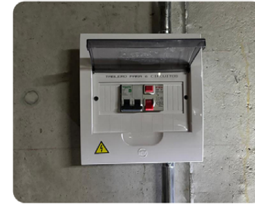
Instalación de tablero y protecciones.
